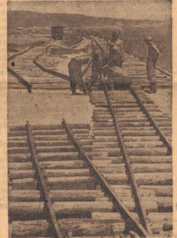
Deutsche Eisenbahn-Pioniere am Kuban. In 24 Stunden haben deutsche Eisenbahn-Pioniere 50 Kilometer Bahngleise von der Breitspur auf die Schmalspur unserer Feldbahnen umgestellt. Besonders an den Nacht- und Weichenstellen muß sehr sorgfältig, oft unter Zuhilfenahme des Schneidbrenners, gearbeitet werden.
