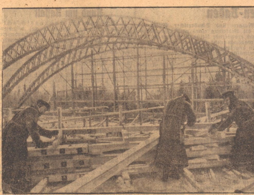
Flugzeughallen entstehen an der Eisenerstraße. Frontarbeiter errichten hier unter schwierigsten klimatischen Verhältnissen Hallen für Flugzeuge.
