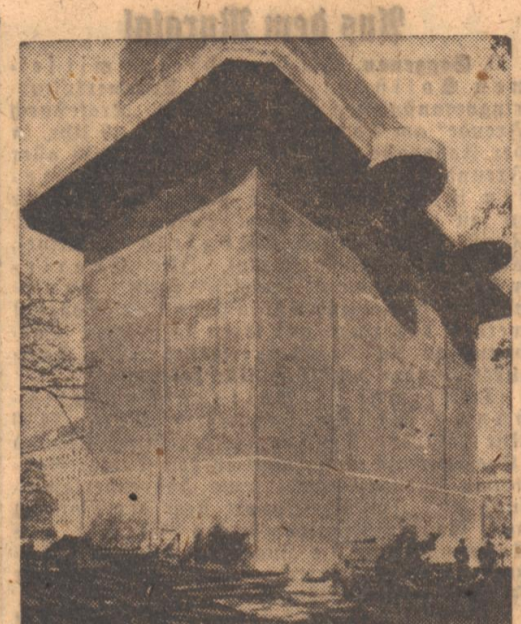
Für Luftabwehr und Luftschutz in luftgefährdeten deutschen Großstädten werden Großbauten aus Beton und Stahl gebaut, die unter dem Namen „Flaktürme“ vollständig geworden sind. Mit der Errichtung dieser Bauten, die gleichermaßen der aktiven Luftabwehr, wie des Luftschutzes der Bevölkerung dienen, hat das deutsche Bauwesen in der Kriegszeit eine bedeutende Leistung während des Krieges vollbracht. (Atlantic-Verlag, Zander-M.)
