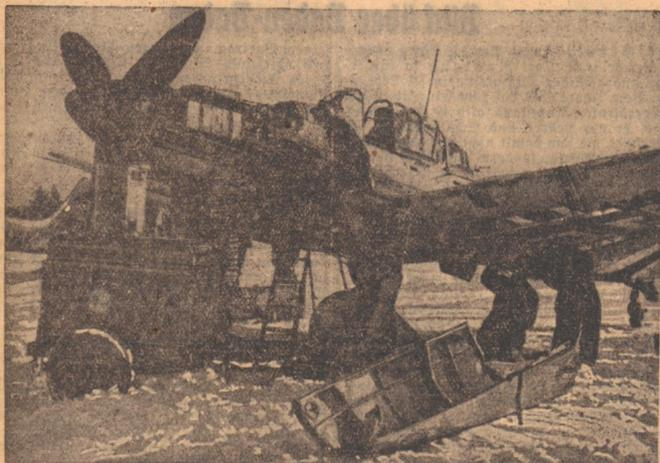
Der "Wärme-Wagen" greift ein. Bei der Feldverfertigung eines Fliegerhorstes an der nördlichen Front: Eine Ju 87 wird wieder einsatzklar gemacht. Im Vordergrund links der bei diesem Wetter wichtige Wärme-Wagen. (PK-Kriegsber. Zwirner (PBZ - Sch))
