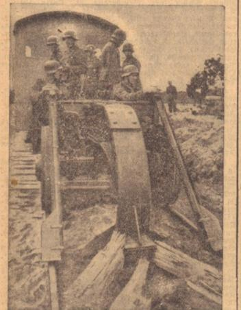
Das Gleiszerstörungsgerät. Hat sich bei den Absetzungen im Osten und in Süditalien hervorragend bewährt.
