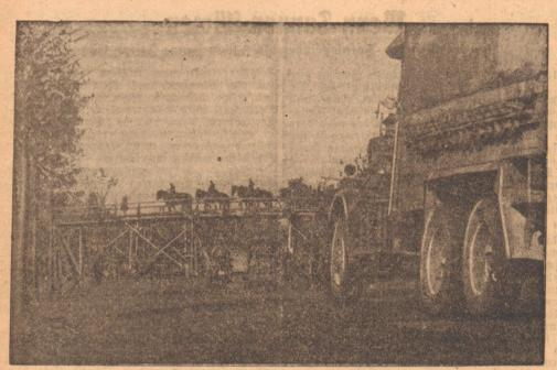
"Hott-Verkehr" über "Mot-Verkehr" an den Kreuzungen der Straßen, über die in unabsehbarer Folge motorisierte Kolonnen und bespannte hrzeuge ziehen, Stockungen zu vermeiden, ist man im lettischen Kampfgebiet dazu übergegangen, aßenbrücken zu bauen. Unser Bild zeigt wie — nach einem Scherzwort der Soldaten — "Hott-Verkehr" er den "Mot-Verkehr" hinwegführt. PK.-Kriegsberichter Schmidt-Scheeder (Sch.).
