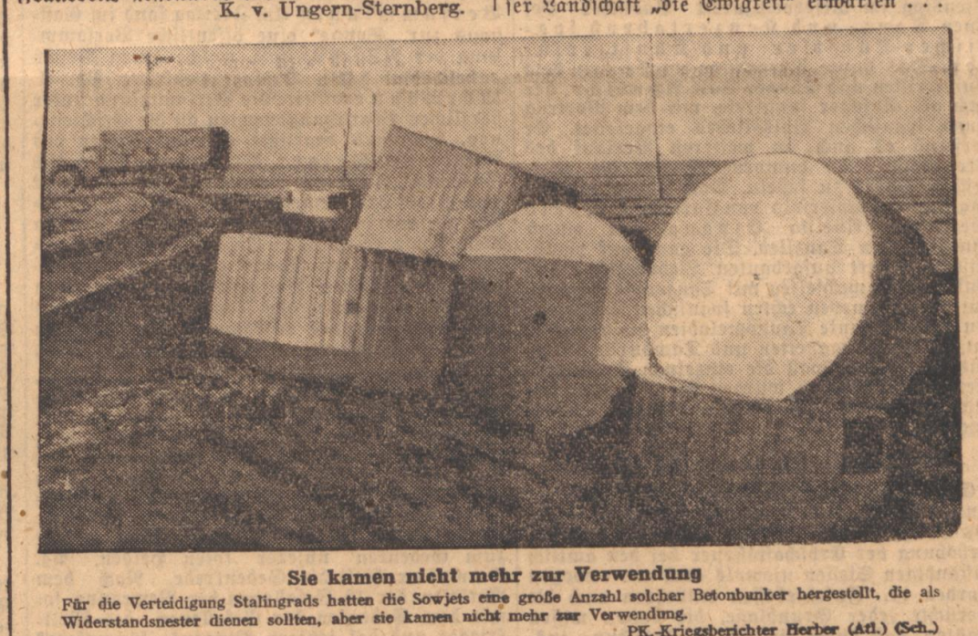
Sie kamen nicht mehr zur Verwendung Für die Verteidigung Stalingrads hatten die Sowjets eine große Anzahl solcher Betonbunker hergestellt...
