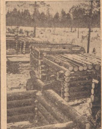
Transportable Bunker. Dort, wo sich im Winter in der H.K.L. Schwierigkeiten zum Bau von Bunkern ergeben, besetzt man ihnen dadurch, daß man im rückwärtigen Gebiet transportable Vier-Mann-Bunker baut, die von schnellsten zusammengebaut sind. — Unser Bild zeigt eine Baustelle, wo Stamm auf Stamm behauen und eingepaßt wird. (PK-Kriegsberichter Freckmann (PBZ-Sch.)
