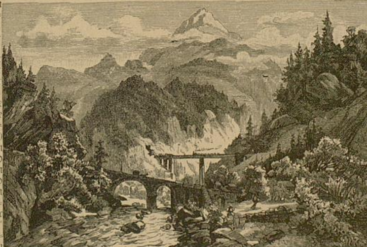
Gotthardbahn. Der große Viadukt im Maderaner Thal bei Amsteg.
