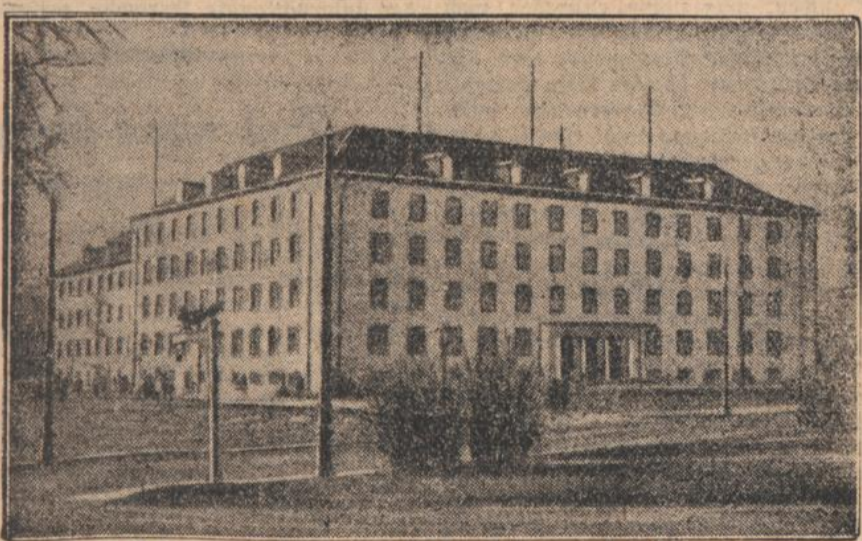
Das neue Gebäude des Wehrkreiscommandos VI, am 12. Januar in Münster i. W. in Anwesenheit von Vertretern der Reichswehr und der Staatsbehörden feierlich eingeweiht wurde.
