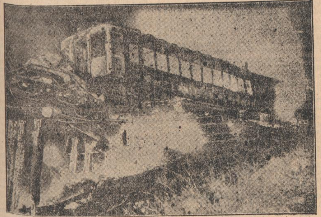
Benzin-Lokomotive verursacht Eisenbahnbrand In der Nähe von Desmoines im Staate Iowa (USA.) stießen zwei Personenzüge auf einer Brücke zusammen, von denen einer durch eine Benzinlokomotive gezogen wurde. Durch den Zusammenprall wurde ein Benzintank beschädigt. Der betankte Brennstoff entzündete sich und setzte die Wagen in Brand. Das Unglück forderte vier Tote und 28 Verletzte.
