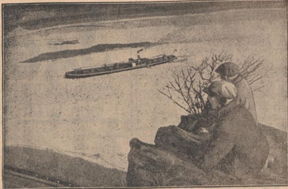
Rheindampfer fest im Eise. Infolge der strengen Kälte ist auch der Rhein zum Teil vereist, so daß die Schifffahrt sehr behindert ist. In der Nähe der Loreley ist — wie unser Bild zeigt — ein Dampfer im Eis festengeblieben. Man versucht, ihn durch Sprengung freizubekommen.
