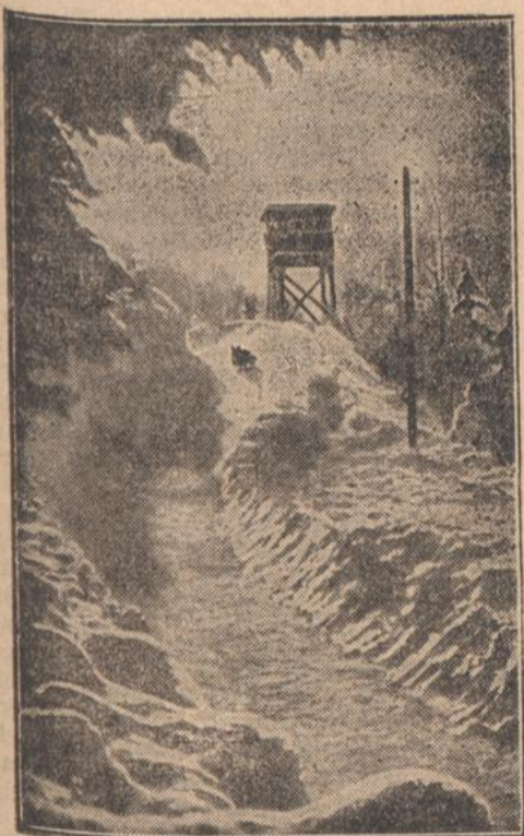
Die neue Olympia-Bobbahn in Garmisch-Partenkirchen.
