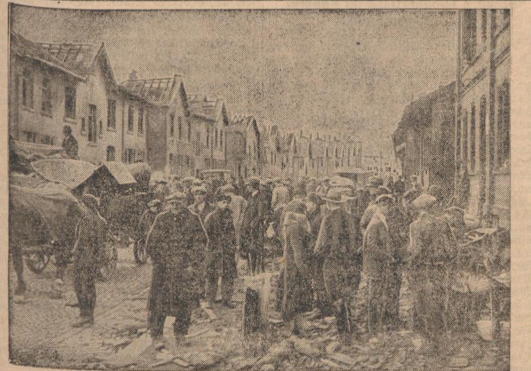
In den Straßen der zerstörten Stadt. Eine Straße der Unglücksstadt Neunkirchen: durch den gewaltigen Luftdruck sind hier sämtliche Dächer abgedeckt worden.
