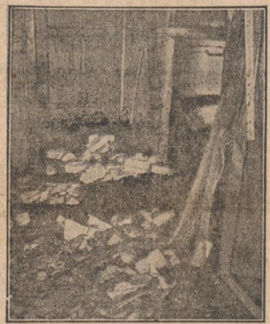
Verföhrungen durch das Erdbeben in Kastatt. Von dem Erdbeben in Baden wurde besonders Kastatt und seine Umgebung betroffen. Zahlreiche Häuser wurden beschädigt, vielfach zeigten sich Sprünge und Risse in den Fassaden. Das Bild zeigt die Trümmer der Zimmerwände in einem Kastatter Haus.
