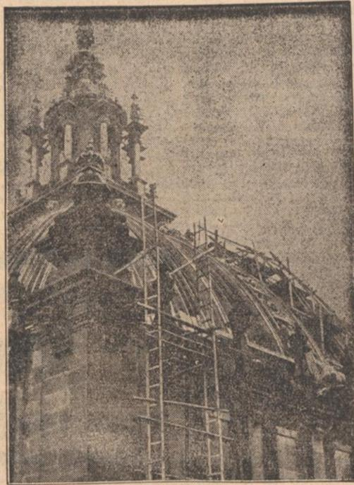
Erste Ausbesserungsarbeiten an der Reichstagskuppel. Aufbau von Gerüsten für Klempner und Glaser an der zerstörten Kuppel des Reichstages. Die Wiederherstellungsarbeiten werden mit großer Beschleunigung durchgeführt.
