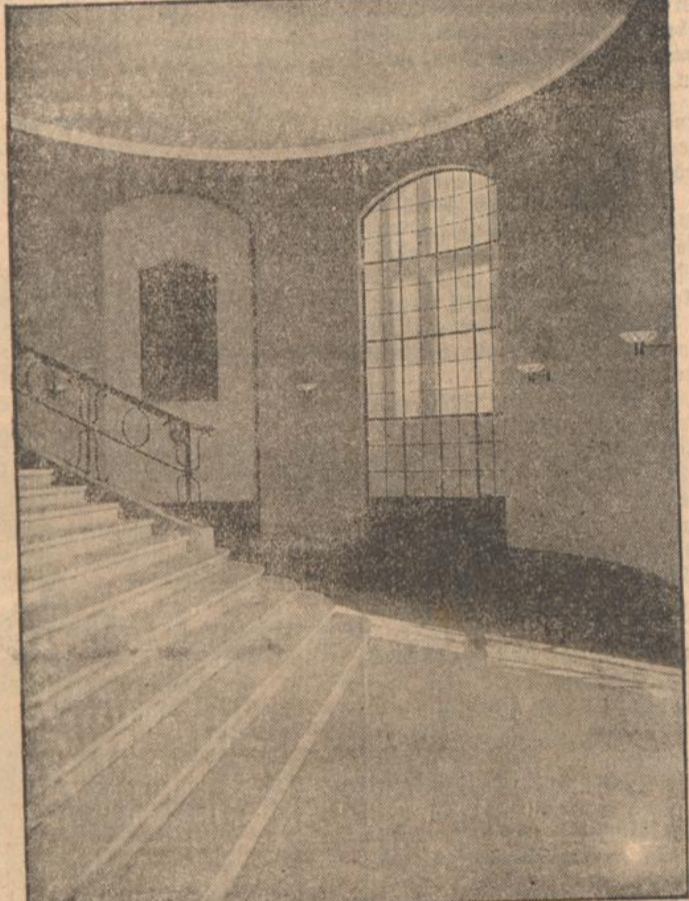
Der neue Treppenaufgang zur Vorhalle
