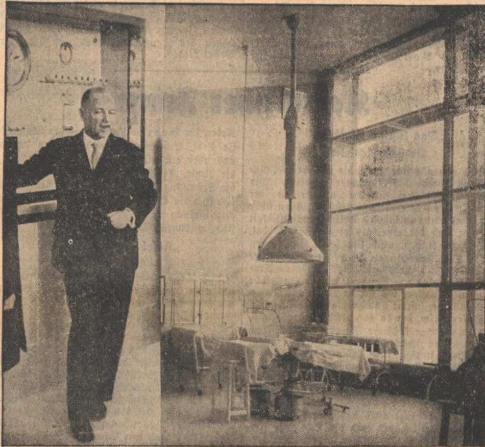
Links: Prof. Trebermann an der Schalttafel des Operationsraums Rechts: Der neue Operationsaal mit Frontfenster und Reflektor
