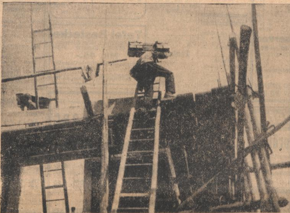
Es wird wieder gebaut.
