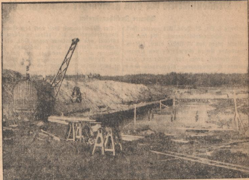
Die Kampfbahn für die Europa-Schwimmerfahrten 1934 im Bau. In Maadburga wird gegenwärtig vom Freiwilligen Arbeitsdienst eine gewaltige Schwimmbahn erbaut, die bereits im August 1934 mit den Kämpfen um die Europa-Schwimmerfahrten eingeweiht werden soll.
