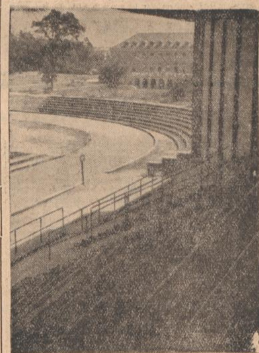
Tribünenbau des Hochschulstadions
