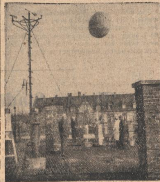
Der Ballon steigt auf. Das Gerüst links ist ein Windmesser, der Windstärke und Windrichtung anzeigt.
