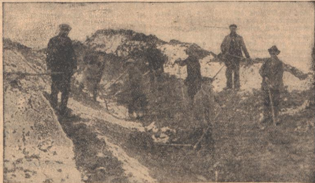
Eine Gruppe Odenheimer Arbeiter am ersten Entwässerungsgraben
