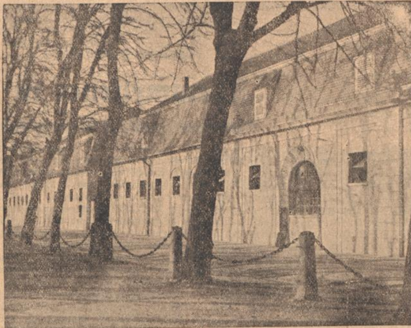
Die Karlsruher Marktsäle, in denen das Armeemuseum untergebracht wird
