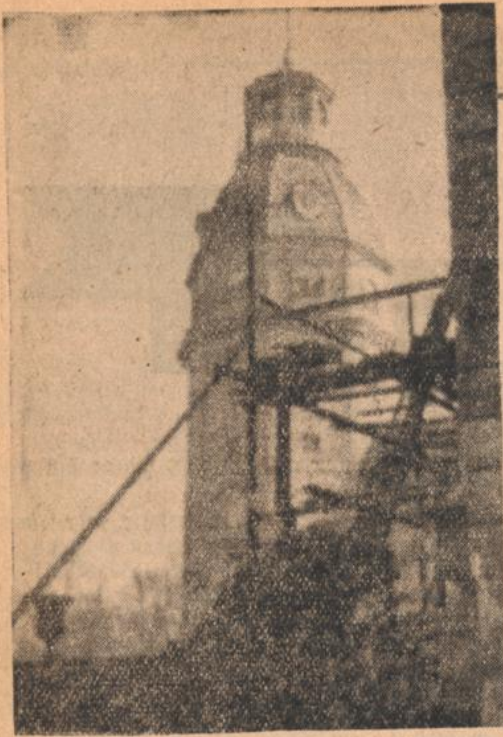
Schloßbau unter Gerüsten
