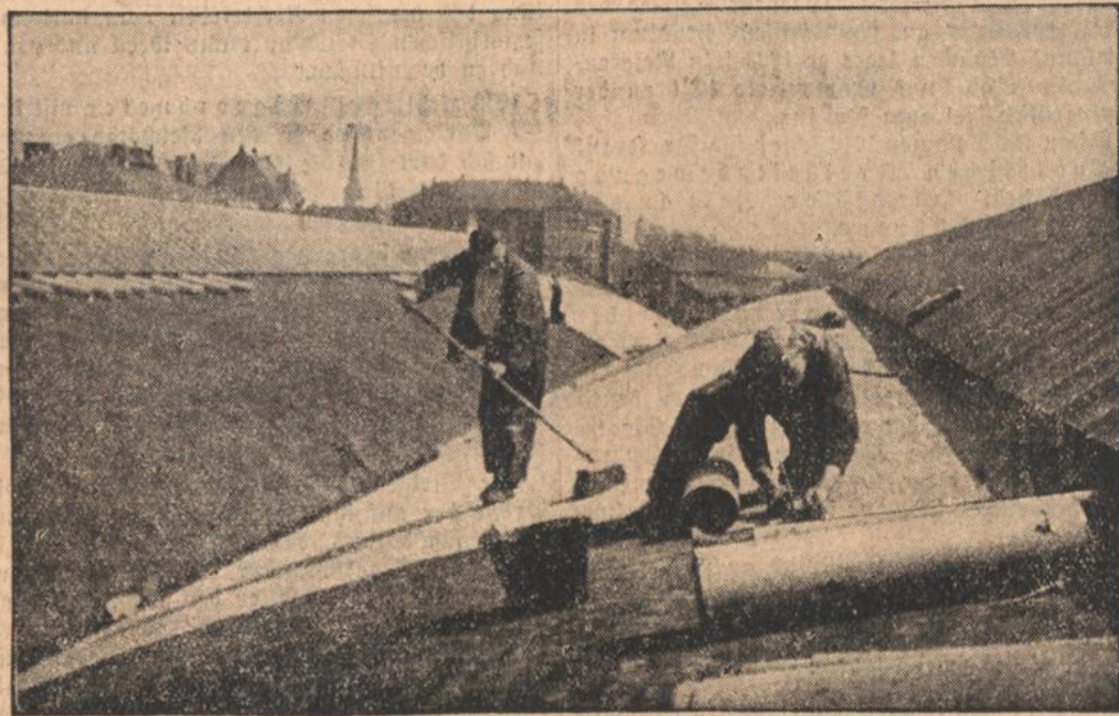
Rechte Hand wird an das Dach angelegt.
