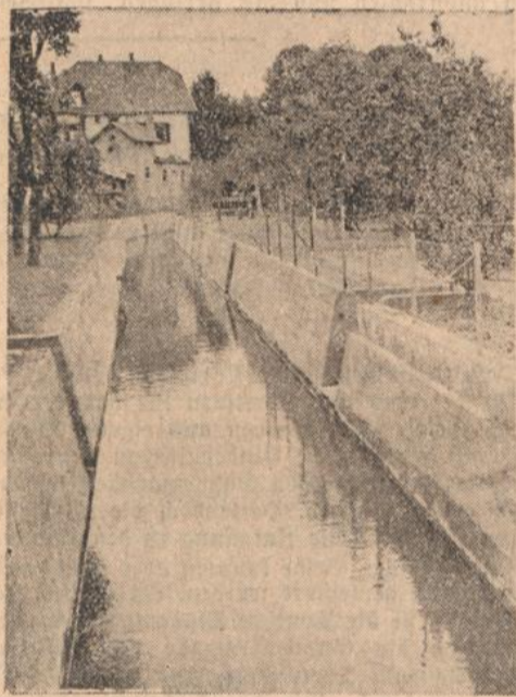
Der fertige Umleitungsgraben bei Hohenheim
