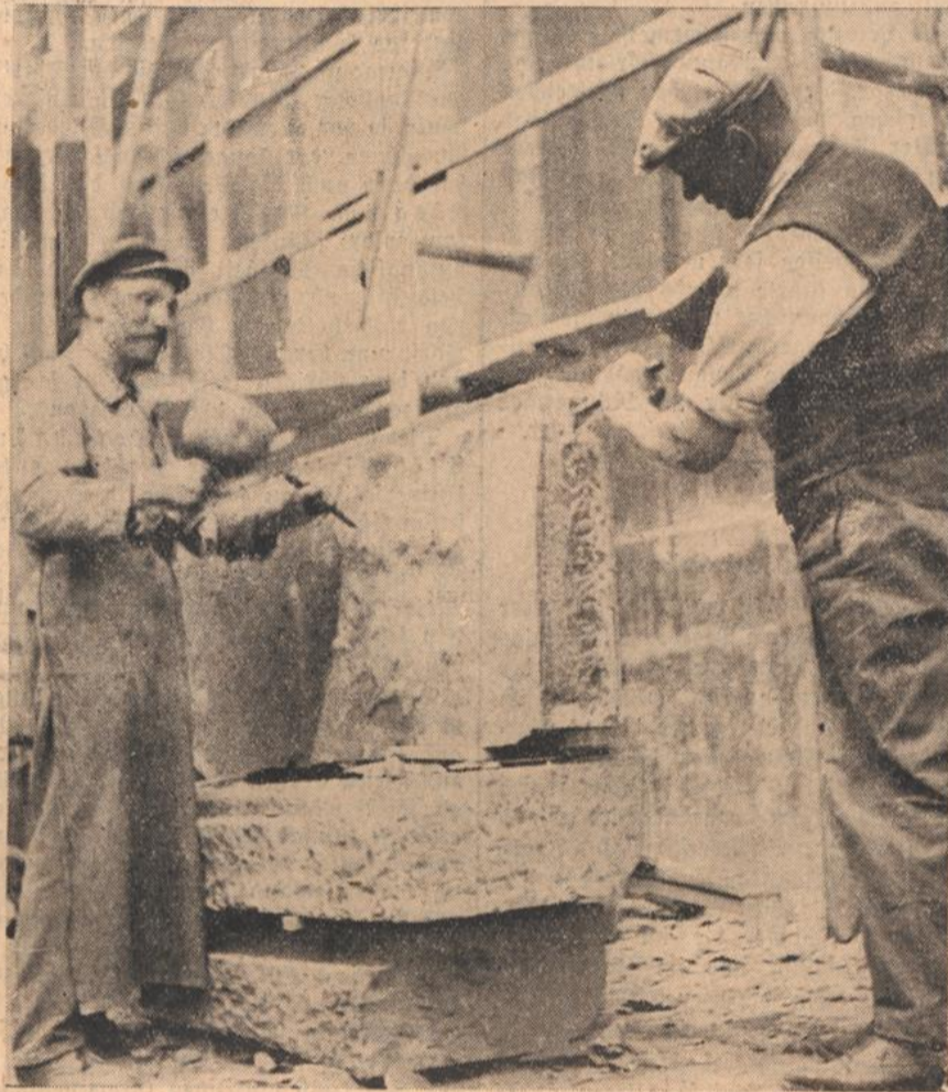
Die Steinhauerarbeiten ausführen. Das Material, das sie verarbeiten, stammt aus dem nahen Wilferdingen.
