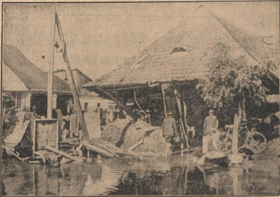
Vom Hochwasser zerstörte Häuser in einem Karpathendorf.
