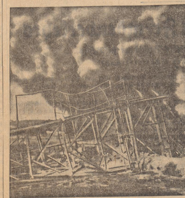
Die Unglücksstätte in Nienhagen Born der zusammengefallene Bohrurm.
