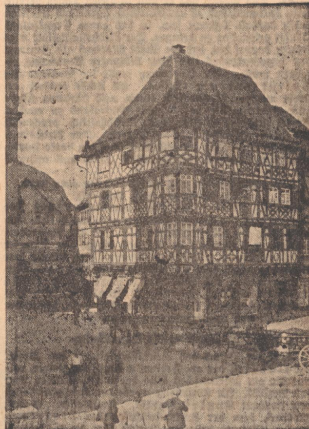
Das Balmste Haus in Mosbach
