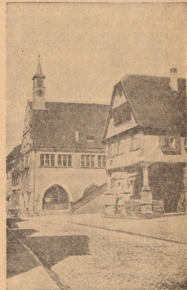
Das alte Rathaus vor dem Umbau
