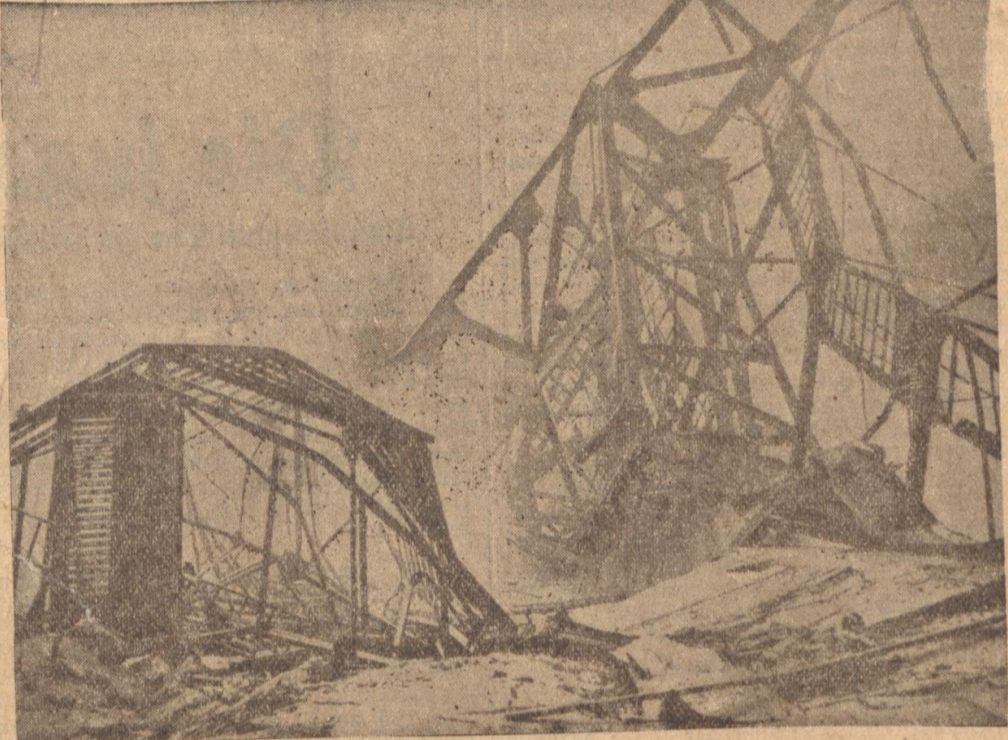
Einsturzungsstück beim Aufbau der Brüsseler Weltausstellung
