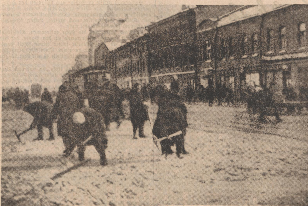
Die Frauen dürfen darum auch die schwersten Arbeiten ausführen. Hier sieht man sie mit schwerer Spitzhacke beim Loseisen der Schneekruste auf dem Sucharewskiplatz in Moskau. (Aufnahme aus „U. d. S.S.R.“, erschienen im Nibelungenverlag, Berlin.)
