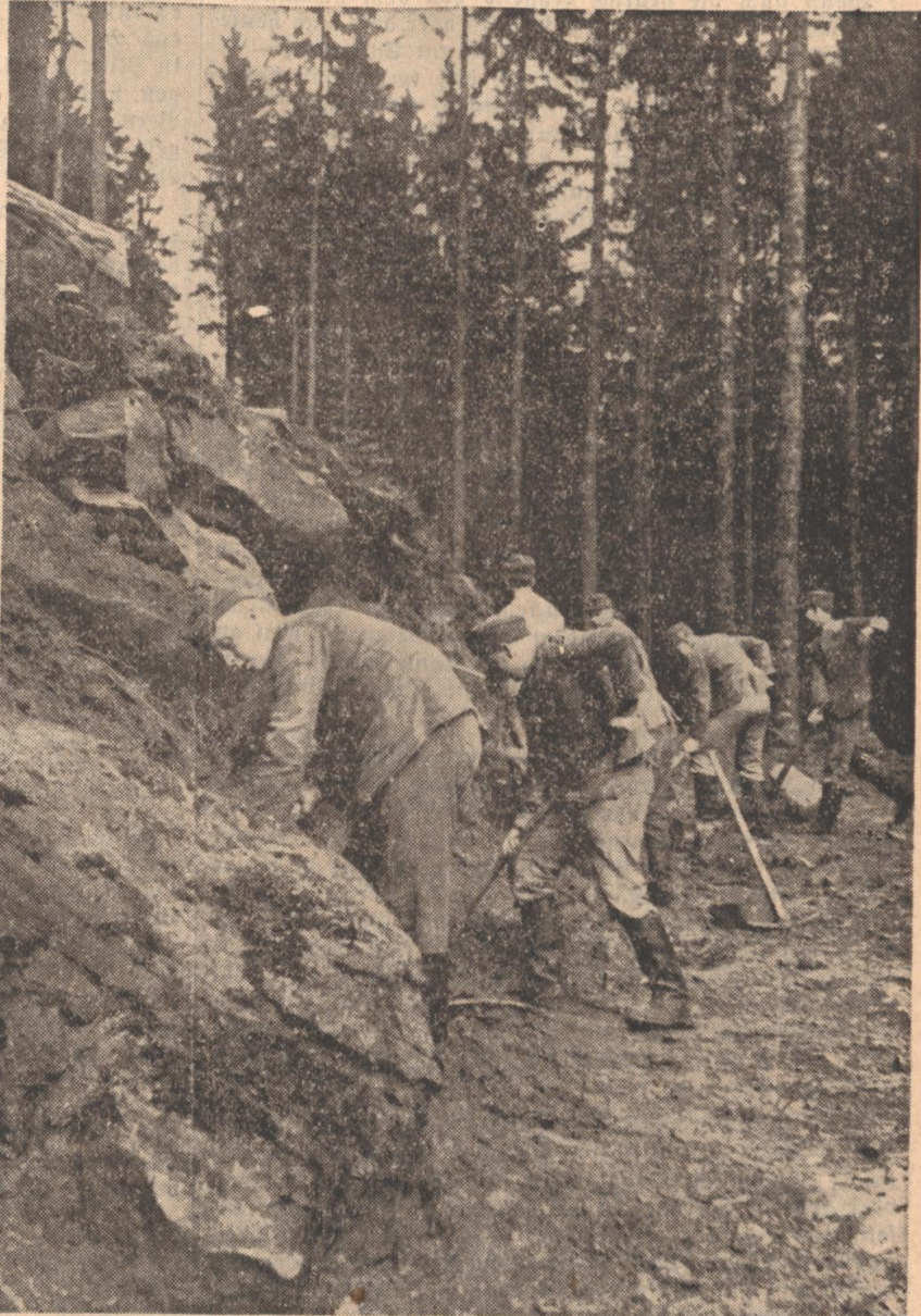
Hart wird der Weg der Bergwand abgetroffen. Aufnahmen: Schwetzer.
