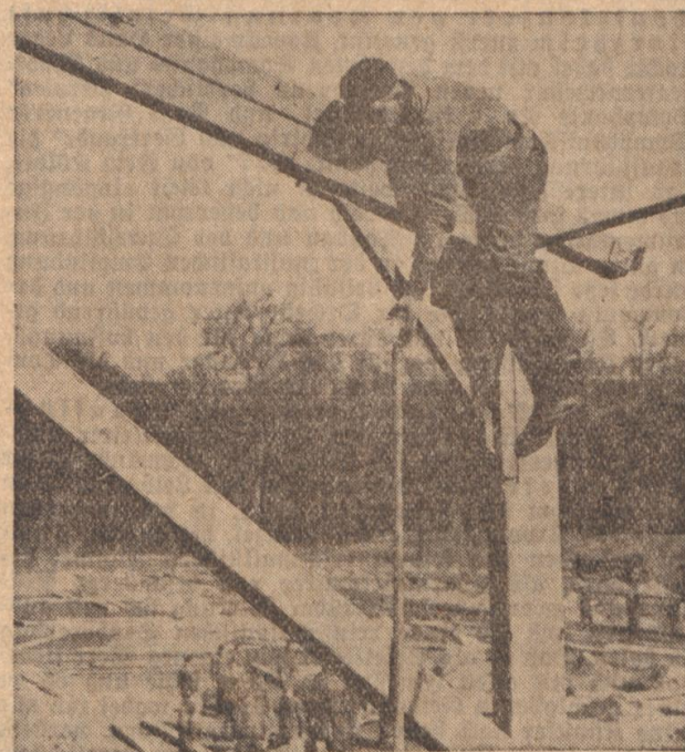
In luftiger Höhe wird gearbeitet Aufnahmen: Lang
