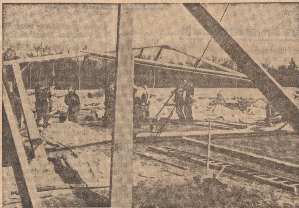
Das gewaltige Gerüst wird aufgerichtet
