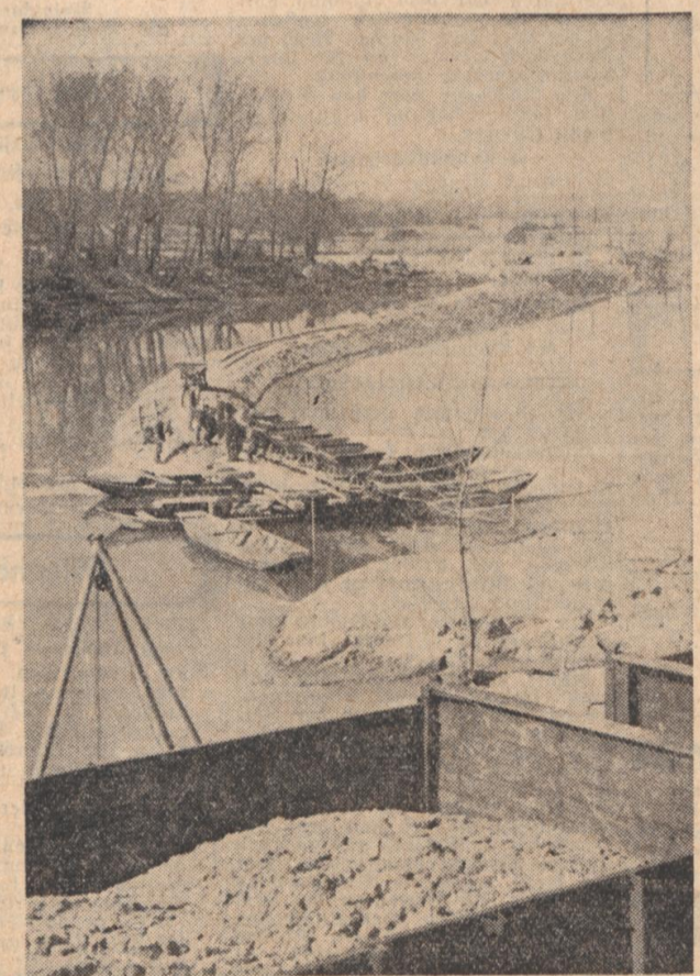
Ein Damm entsteht im alten Baggersee
