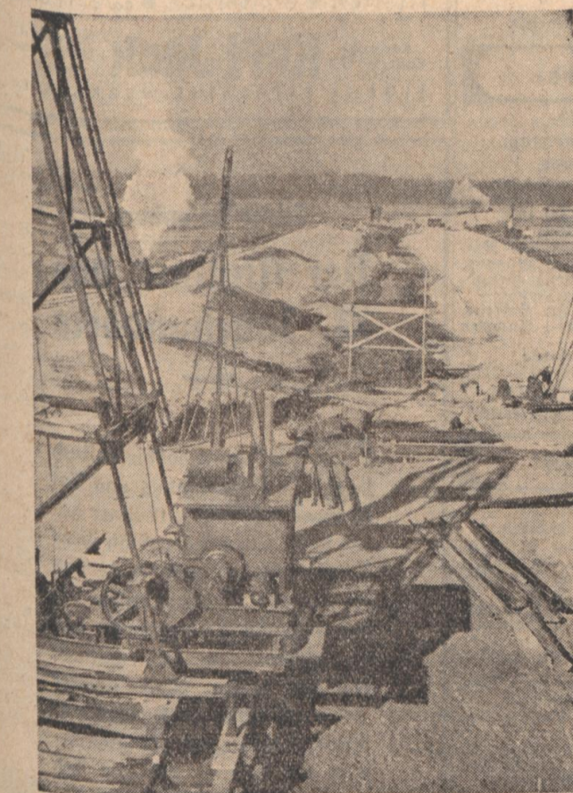
Der Rammbod schafft Wände für einen Dücker
