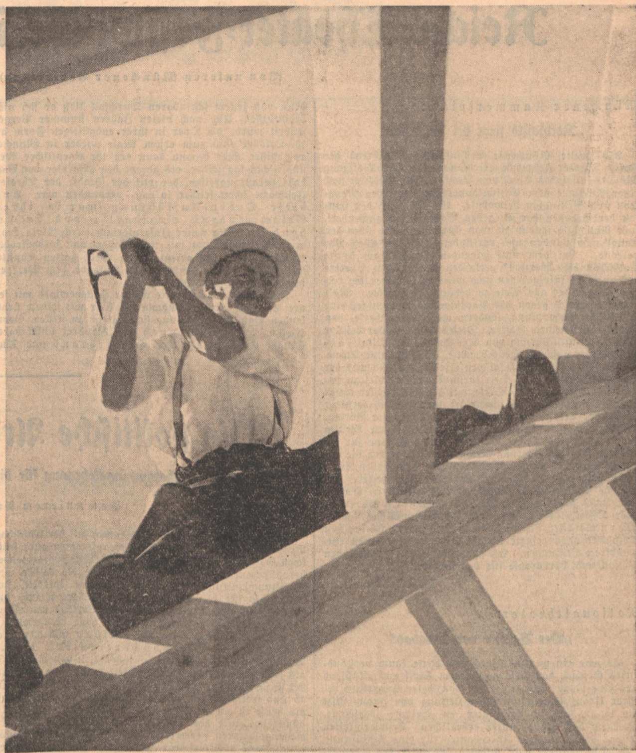
Der Zimmermann baut den Dachstuhl
