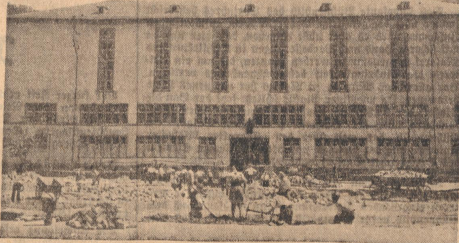
Berühmungsarbeiten vor dem neuen Universitätsgebäude. Aufnahme: Bauer
