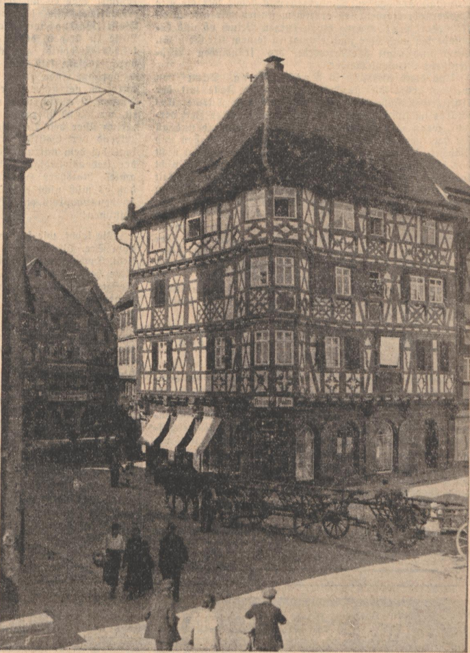
Der bekannte Fachwerkbau, das Palm'sche Haus in Mosbach Aufnahme: Reichsbahnbildstelle Karlsruhe
