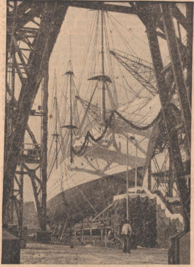
Das neue Schulschiff „Horch Wesel“ Das Schweißschiff von „Horch Wesel“ auf der Werft von Blohm & Bohn in Hamburg. (Atlantia, A.)
