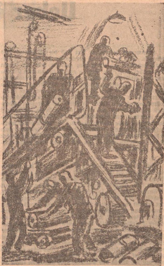
Eine moderne Rotationsmaschine wird aufmontiert.
