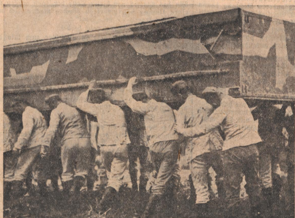
Ein Ponton wird abgeladen.
