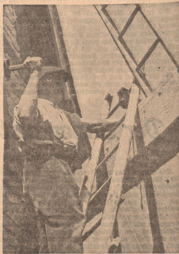
Brett fügt sich an Brett, bis die Wand steht
