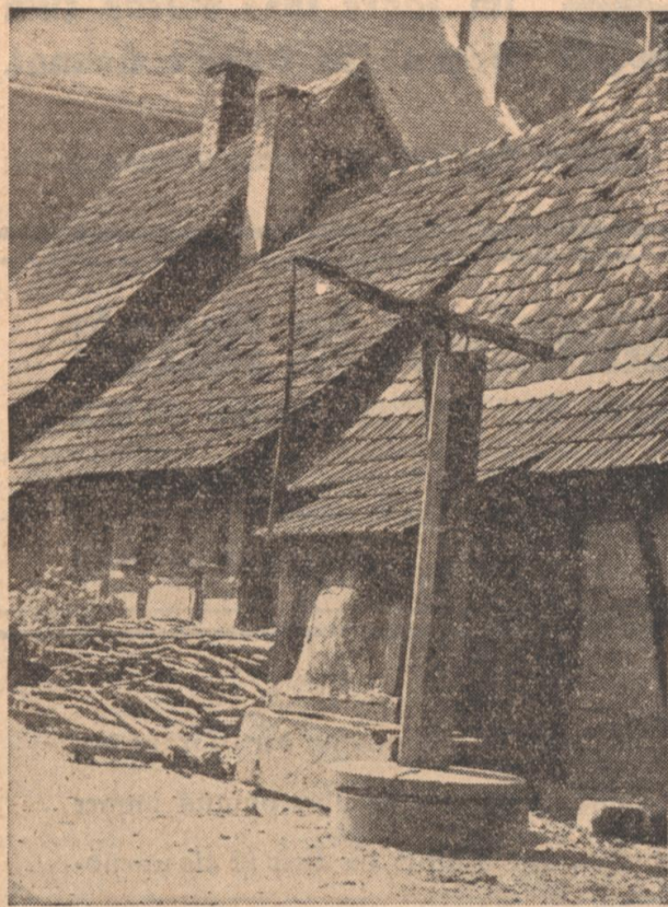
Graben: Blick in einen alten Hof
