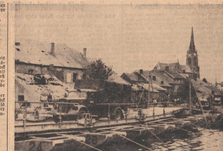
Behelfsbrücke. Fest und sicher steht die von den Pionieren in rascher Arbeit erbaute Behelfsbrücke. Sie trägt auch schwere Lasten. (P.A.-Ulrich-Brosche-Solmann)
