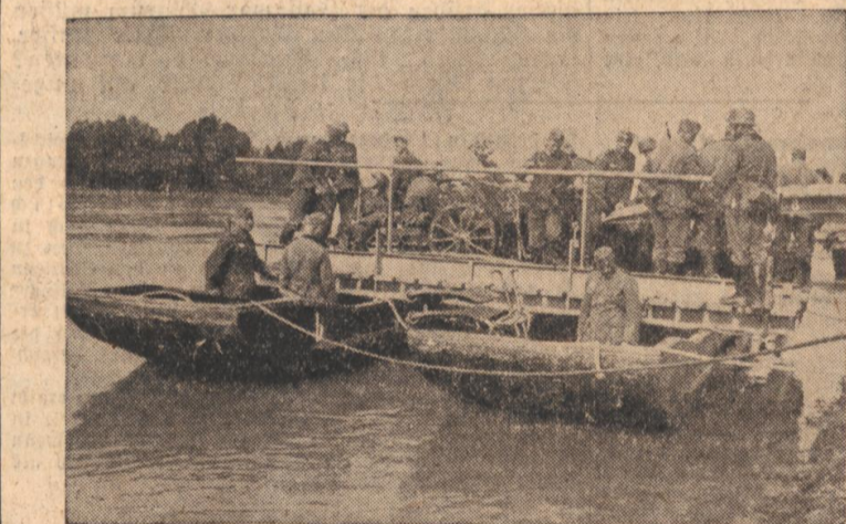
Zwei Bilder vom Rheinübergang der Wehrmacht: Pontonfähre fertig zum Ubersetzen.
