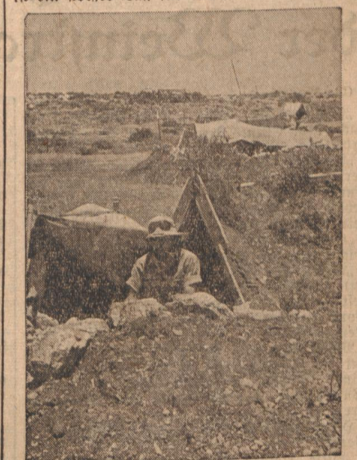
So wohnen unsere Soldaten in Afrika. Die Zelte, in denen unsere Soldaten an der nordafrikanischen Front wohnen, sind vielfach in die Erde eingebaute. Auf diese Art erzielt man nicht nur eine gute Tarnung, sondern auch einen besseren Schutz gegen die Hitze. Natürlich ist jeder Soldat außerdem bemüht, seiner Wohnung möglichst eine persönliche Note zu geben, so daß bei diesem Zeltbau richtige „Erdburgen“ entstehen. (PK-Mühlbrandt-Scherl-M.)
