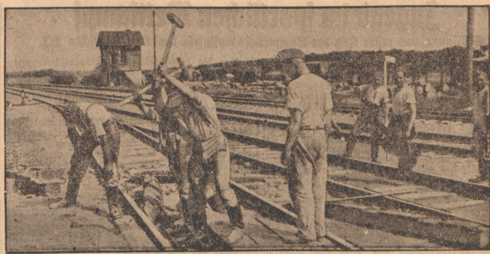
Russlands Eisenbahnschienen werden europäisiert. Eisenbahntiere verlegen die Schienen der Sowjetbahnen dicht vor Kowno auf Normalspur. Bekanntlich haben die russischen Bahnen eine größere Spurweite, als die in den übrigen europäischen Ländern. (PK-V. d. Piepen, Presse-Hoffmann, M.)
