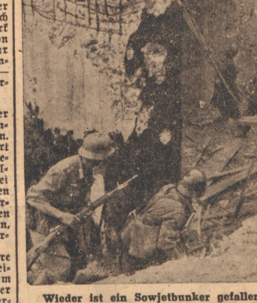
Wieder ist ein Sowjetbunker gefallen (PK. Harschneck, Pross-Hoffmann, Z.-M.)
