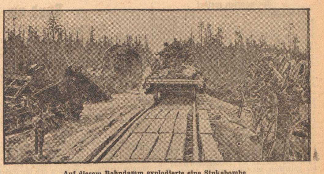
Auf diesem Bahndamm explodierte eine Stukabombe. Die Wirkung war verheerend. Der darüberrollende Eisenbahnzug ging vollständig in Trümmer. Rechts und links der Schienen liegen die verborgenen und zerschmetterten Überreste. Inzwischen haben die Pioniere kräftig Hand angelegt und die wichtige Strecke in Ostkarelien ist wieder befahrbar. (PK-Atlantik, Zander-M.)
